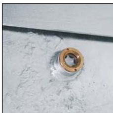
Vue détaillée : détection de fuite permettant de vérifier l'étanchéité de la cuve
