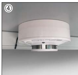
Sonde thermique directement derrière le détecteur de fumée
