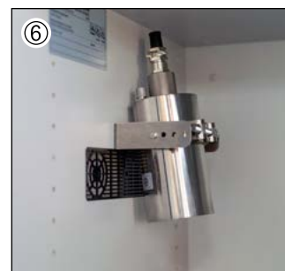
Système d'extinction d'incendie
