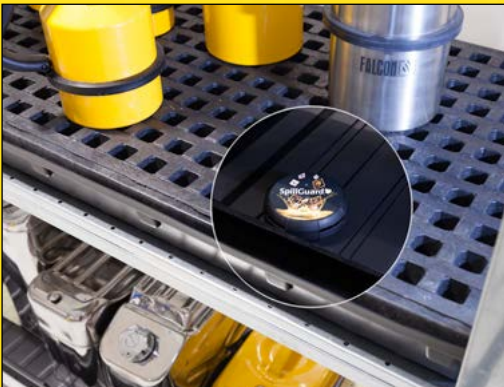
SpillGuard® sur une étagère de marchandises dangereuses avec bac de rétention en plastique.
