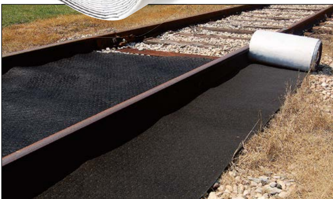
Utilisation sur voie ferrée : le tapis large s'insère précisément entre deux rails. Le tapis étroit permet de protéger les bas-côtés.
