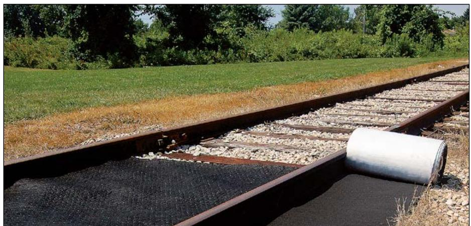
Utilisation sur voie ferrée : le tapis large s'insère précisément entre deux rails. Le tapis étroit permet de protéger les bas-côtés.
